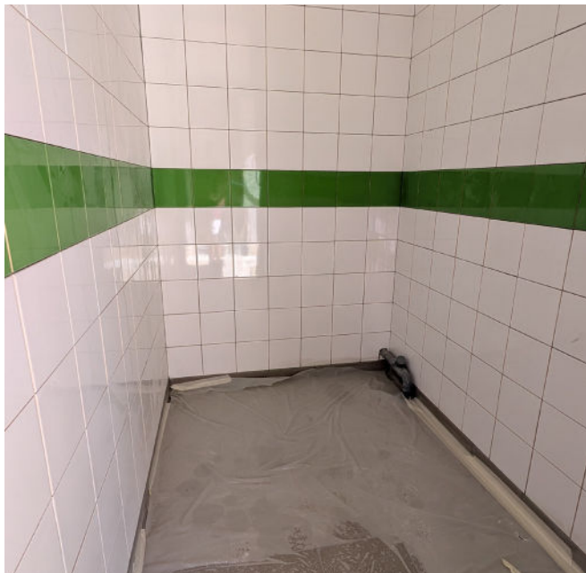
Rénovation des sanitaires à l'école Paul-Bert
