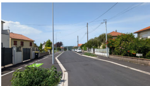
Rue de Verdun - Coût des travaux : 1 853 000 € TTC
