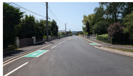
Avenue des Vosges - Coût des travaux 439 121 € TTC
