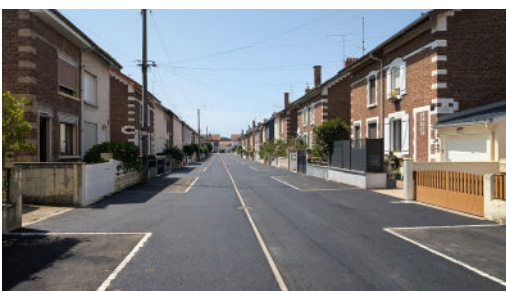
Rue Fabert - Coût des travaux : 179 525 € TTC
