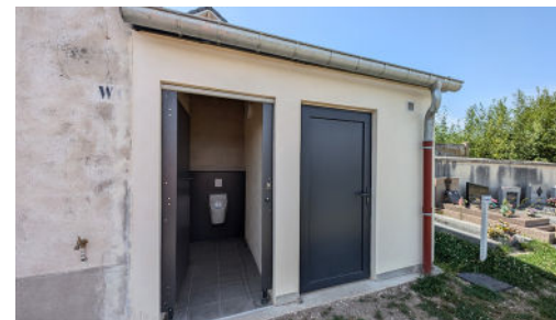
WC du cimetière - Coût des travaux : 26 154 € TTC
